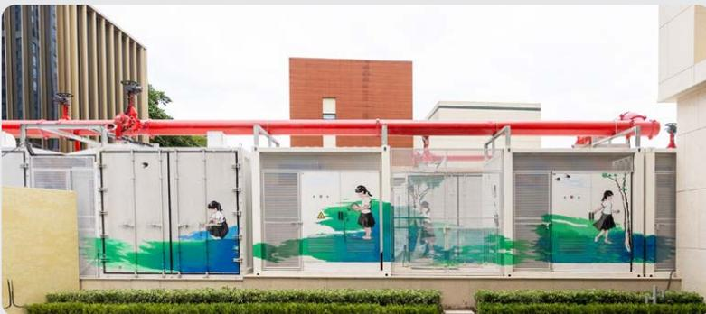
光充儲系統，設置54槍低碳快充設施，以儲能系統供應充電樁、大樓電力和緊急備源用電，達到削峰填谷。
